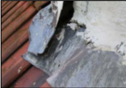
ventilatiekanalen loodslabben
